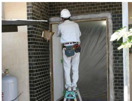
壁を壊す、一般的な玄関交換の場合
